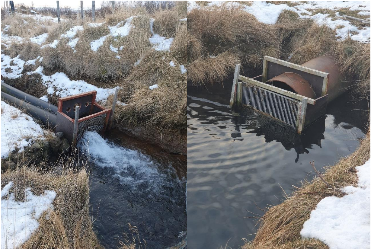
MYND 2.7 Ristargildir við innrennsli og útrennsli settjarnar
