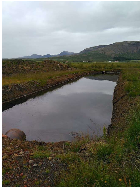
Mynd 1 a, b. Tvær setprær sem allt frárennsli frá eldisstöðinni Eyjarlandi rennur um. Yfirfall úr setpró til hægrri rennur alls 3,4 km leið (í opnum skurði og ám) áður en það fellur í Apavatn.
