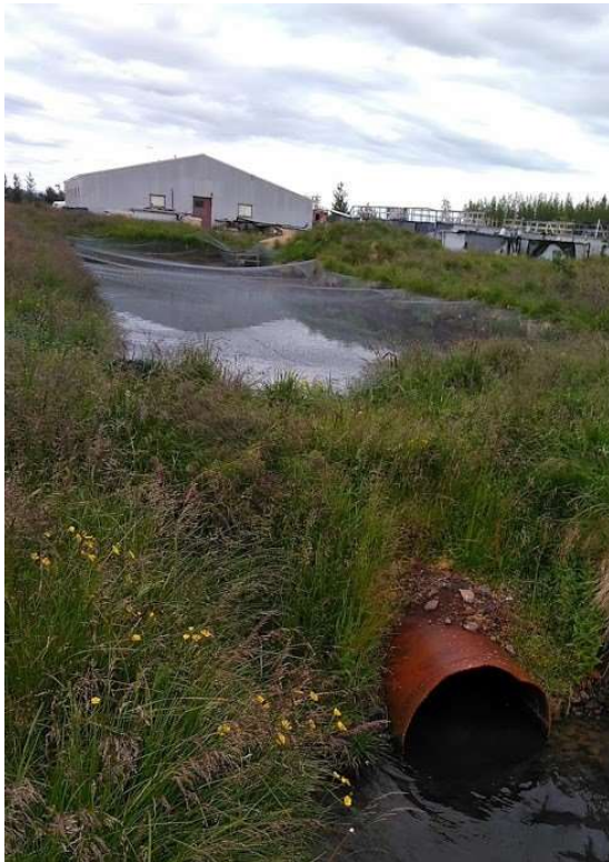
Mynd 1 a, b. Tvær setprær sem allt frárennsli frá eldisstöðinni Eyjarlandi rennur um. Yfirfall úr setpró til hægrri rennur alls 3,4 km leið (í opnum skurði og ám) áður en það fellur í Apavatn.
